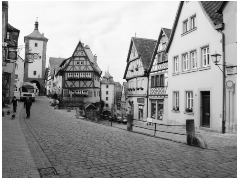
図1 Rothenburg 中心の町並み。数百年そのまま傾斜地に立っているレンガ造り
